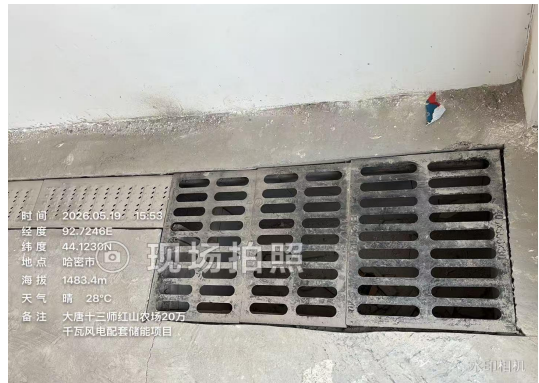
危废暂存间内废液导流槽及收集装置
