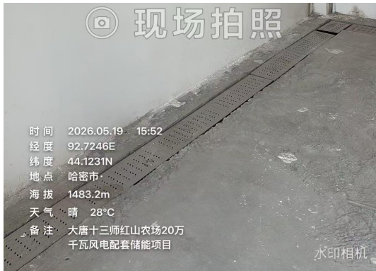
危废暂存间内废液导流槽及收集装置
